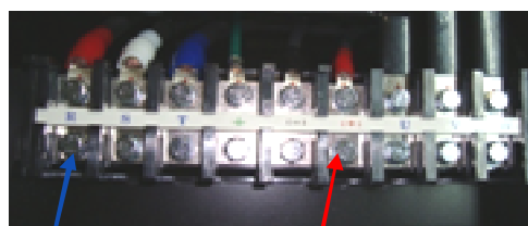
Щуп COM прибора к клемме R
