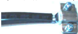
Рис. 6.20. Демонтаж датчика температуры.
