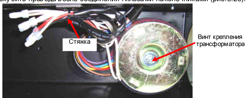
Рис. 6.26. Демонтаж трансформатора питания вентиляторов.
