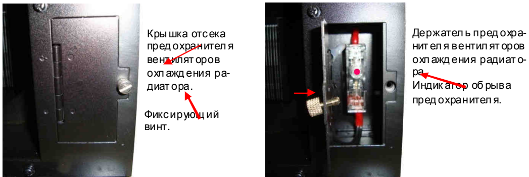
Рис. 4.26. Предохранитель цепи питания вентиляторов охлаждения радиатора
